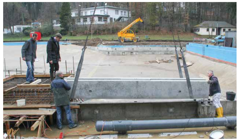
Beckenrandsanierung 2013/14 | Foto: Jana Eilhardt 29.11.2013
