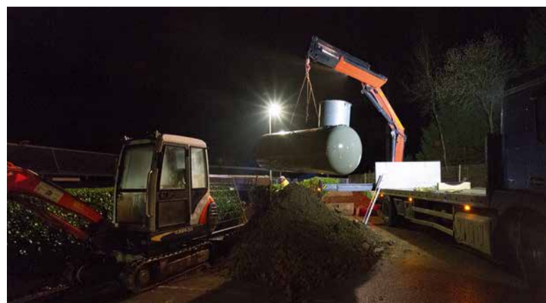
Kleine Nachtaktion: Anlieferung des neuen Gastanks am 11.12.2018
