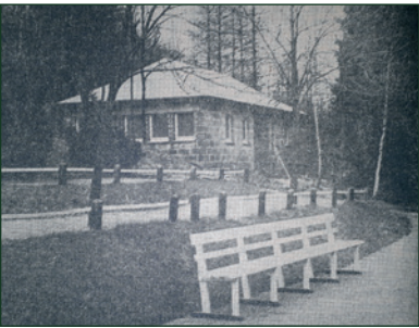
Das neue Toilettenhäuschen 1961
