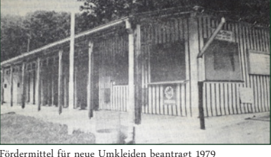
Fördermittel für neue Umkleiden beantragt 1979
