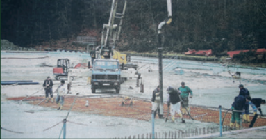
Neuer Betonboden für das Herpinebecken 2000
