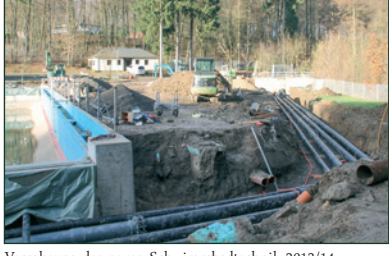
Verrohrung der neuen Schwimmbadtechnik 2013/14
