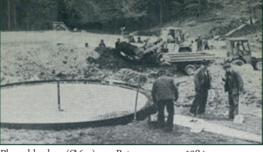
Planschbecken (Ø6m) aus Beton gegossen 1984
