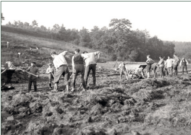
Von Hand ausgeschachtet! Bau der Herpine 1932
