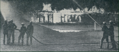
»Warmer Abriss« des alten Umkleidegebäudes 1981
