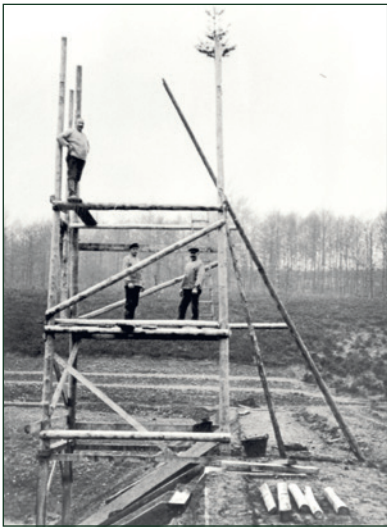
Bau der Herpine 1932
