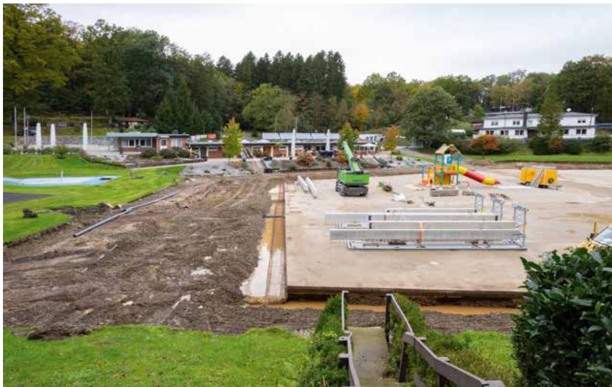
Große Baustelle um das Nichtschwimmerbecken | Foto: Jana Eilhardt 23.10.2023
